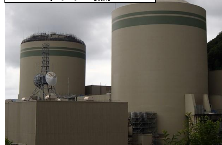
格納容器上部遮蔽設置工事の状況 (2020.7時点)
