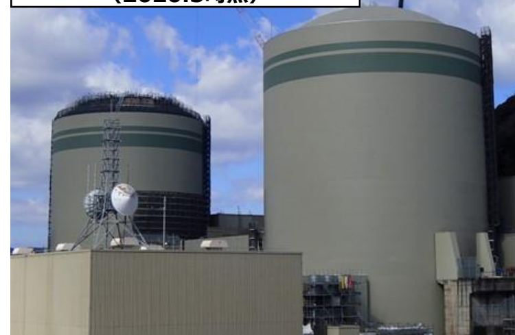
格納容器上部遮蔽設置工事の状況 (2020.3時点)
