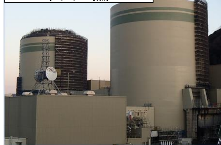
格納容器上部遮蔽設置工事の状況 (2020.1時点)
