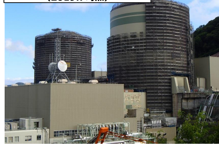
格納容器上部遮蔽設置工事の状況 (2019.7時点)
