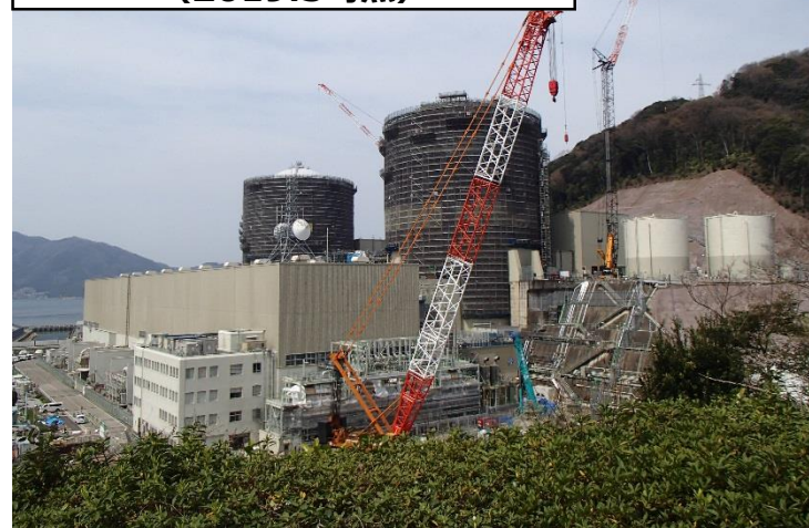
格納容器上部遮蔽設置工事の状況 (2019.3時点)
