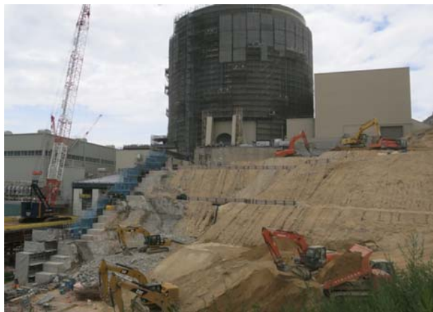
既存高台の掘削
