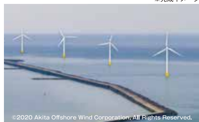
【洋上風力】秋田港及び能代港※ (提供: 秋田洋上風力発電株式会社)
