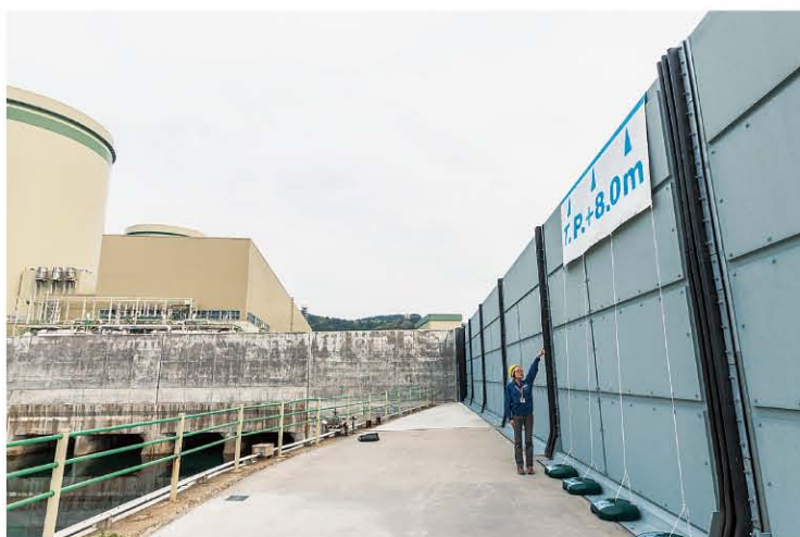
①放水口側防潮堤
