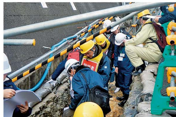
敷地内での剥ぎ取り調査箇所を確認
