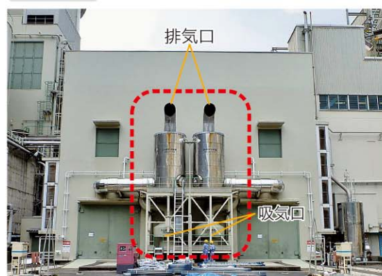
高浜発電所3号機の例 吸気口を標高約5.8mから約19.3mにかさ上げ
