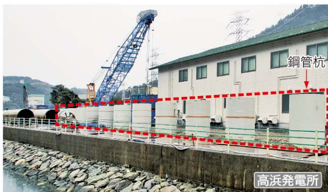
防潮堤設置工事の様子
