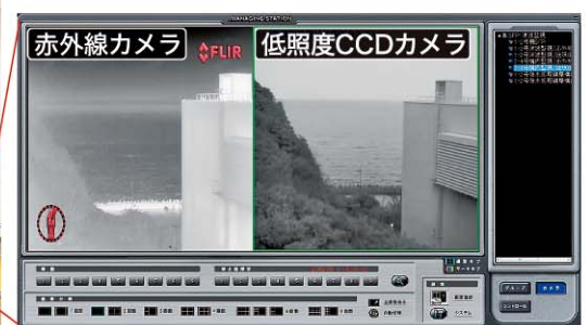
中央制御室内の「事故時補助監視盤」のモニターに表示
