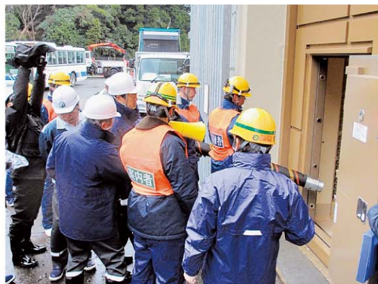
可搬式代替低圧注水ポンプの調査（大飯発電所）
