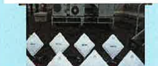
衛星電話(屋上アンテナ)
