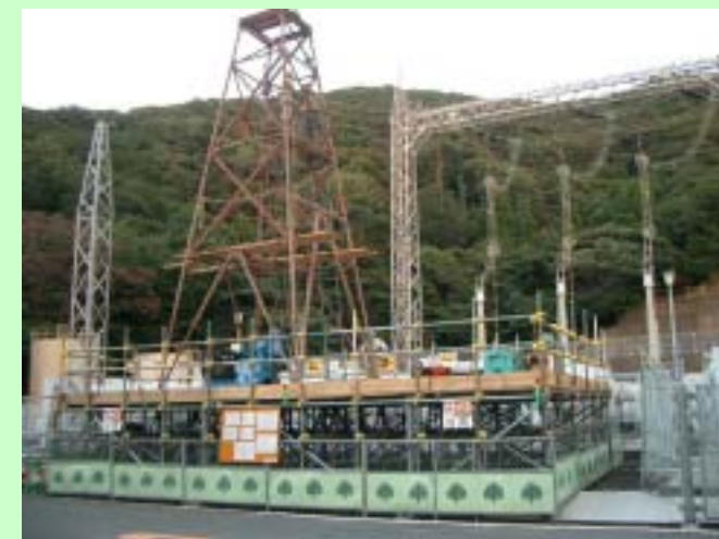
【ボーリング調査】
