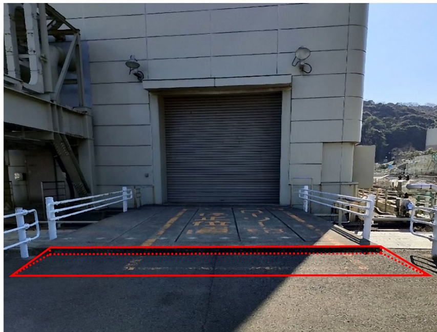
第 2.4.5 図 改善対策例（復水処理建屋搬入シャッター前段差のスロープ設置イメージ）
