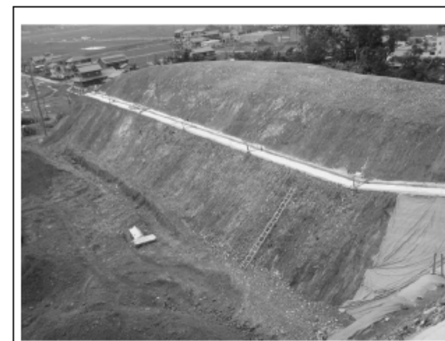
東側法面写真 (長さ約70m, 高さ約12m)
