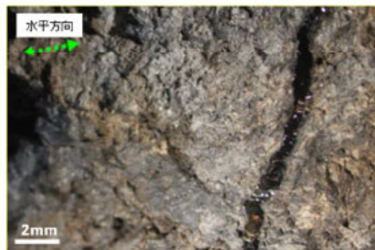
断層面の状況 条線は認められない
