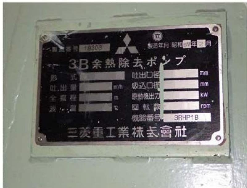
図 19・1 3A 余熱除去ポンプ, 3B 余熱除去ポンプ
