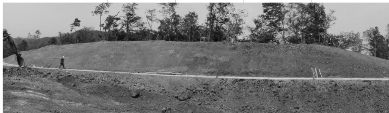
西側法面写真（長さ約90m、高さ約12m）
