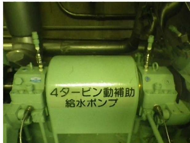
図27-1 4タービン動補助給水ポンプ
