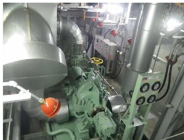
図27-2 4タービン動補助給水ポンプ
