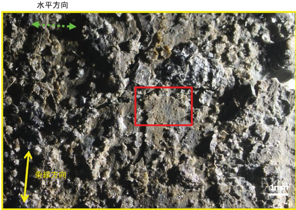
断層面の状況
