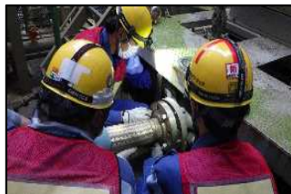
仮設中圧ポンプ接続訓練
