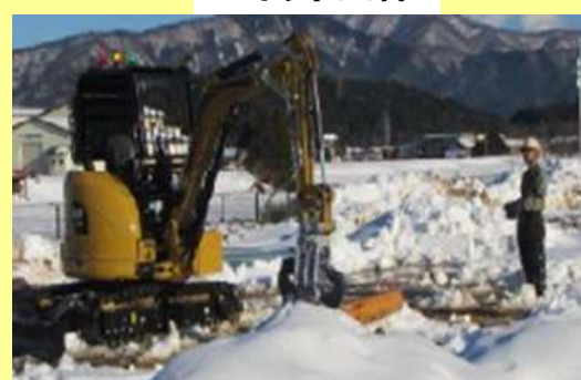
無線重機訓練
