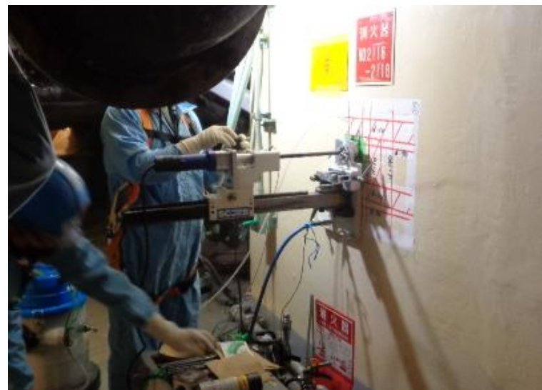
【 コンクリート試料採取状況 】
