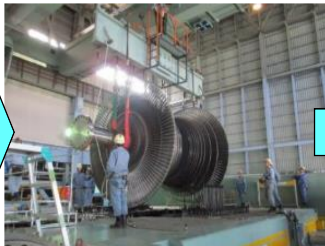
【解体撤去の例（低圧タービン）】
