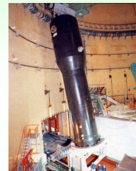
(蒸気発生器の取替え)
