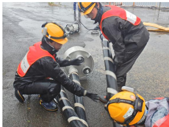
能登半島地震を踏まえた 地盤隆起時の可搬型設備による海水取水訓練 （大飯発電所）
