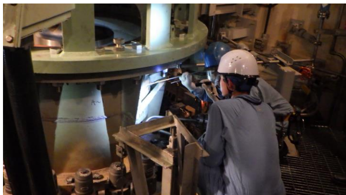
高浜2号機再稼動時の現場点検の様子 (1次系冷却材ポンプの運転状態の確認)
