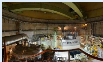
見学（原子炉格納容器内部）
