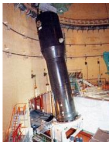
▲蒸気発生器の取替え
