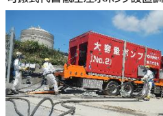
大容量ポンプ設置訓練
