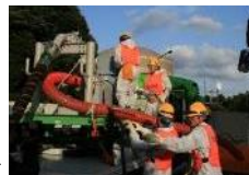
可搬式代替低圧注水ポンプ設置訓練
