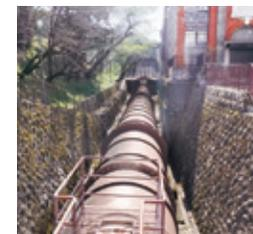
琵琶湖疏水から発電に使用する水を引き込む赤茶色の水圧鉄管。その大きさは見応え十分！
