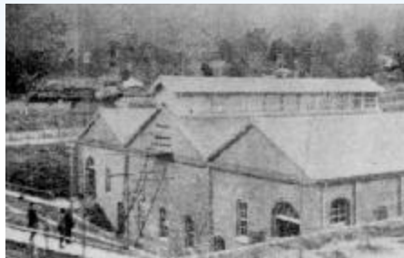
第1期 蹴上発電所 1
