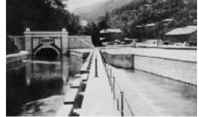
蹴上放水路(台流トンネル北口) 22
