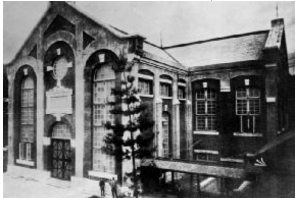
第2期 蹴上発電所建物 23
