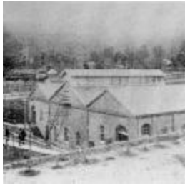
第1期 蹴上発電所建物 10
