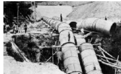
送水鉄管取付工事(第2期工事) 3
