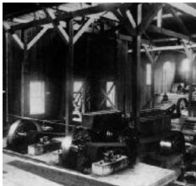
初期の発電所内部 16
