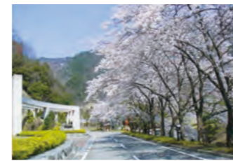
奥多々良木発電所 (機器搬入路トンネル入口)
