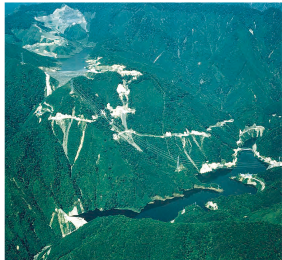
上部ダム(瀬戸ダム)と下部ダム(旭ダム)
