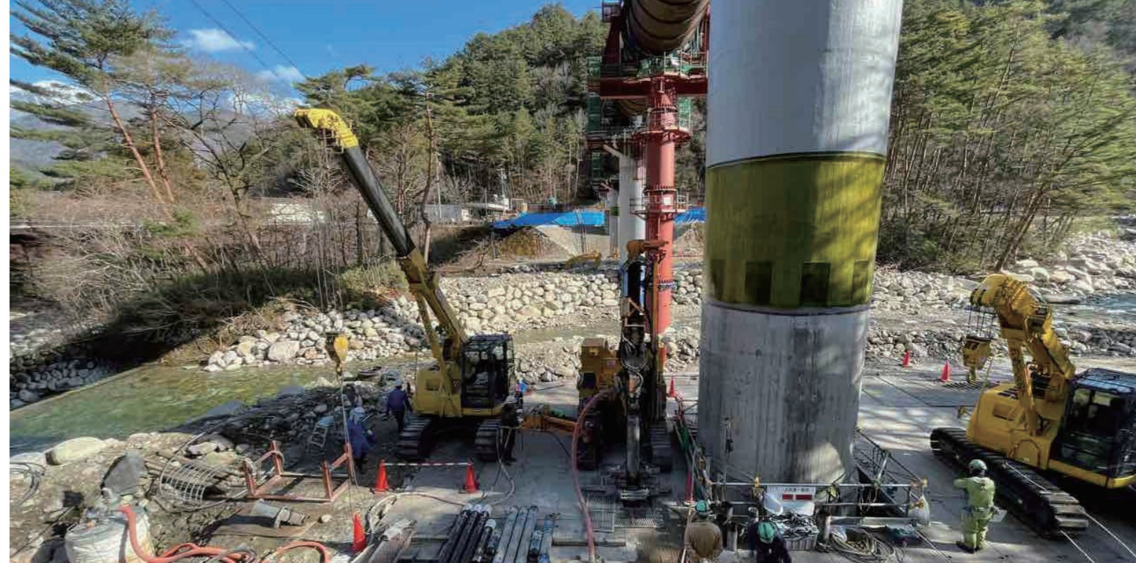
工事の進む小川水路橋
