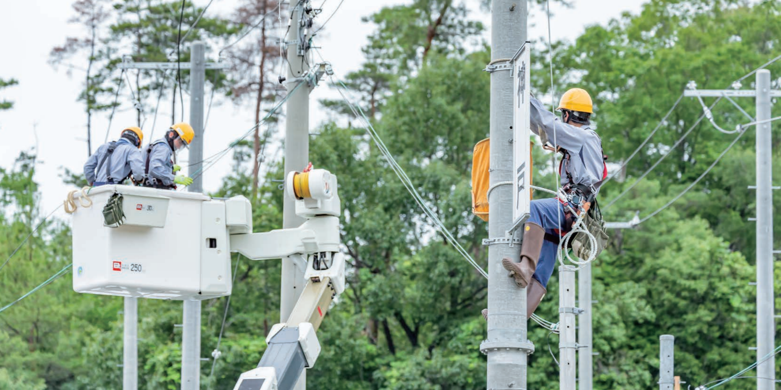
高圧線の仮復旧訓練
