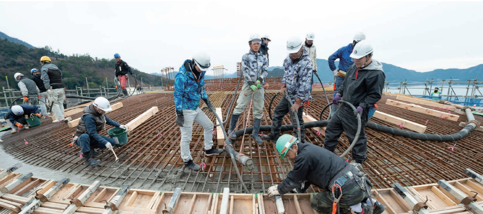
トップドーム設置工事
