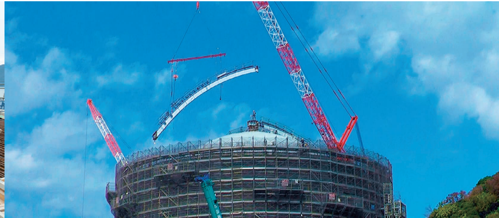
安全確保を最優先に取り組んだクレーン作業
