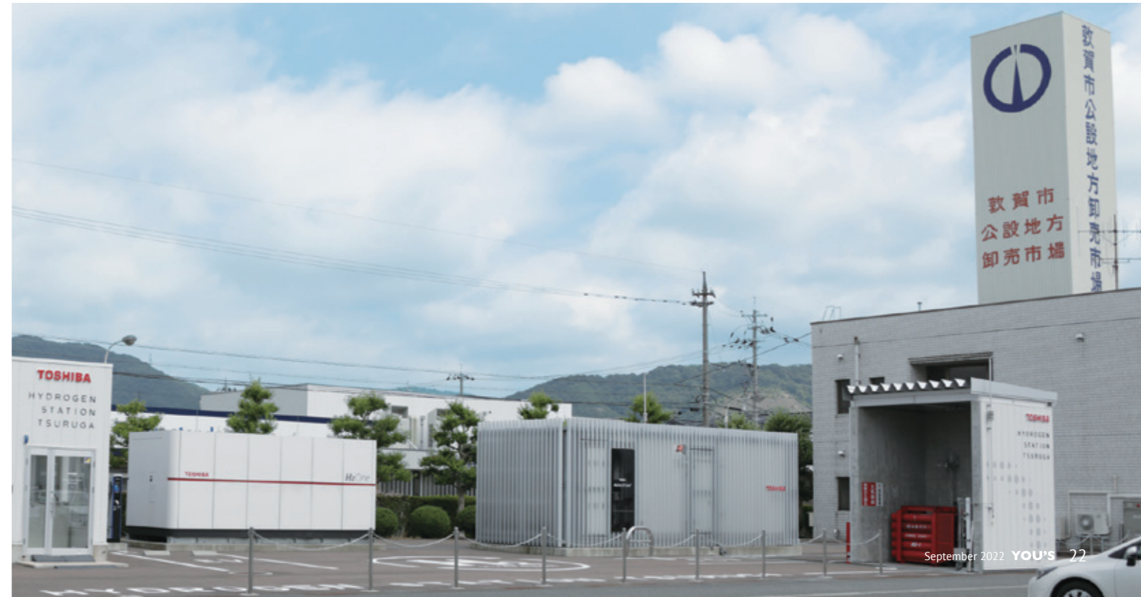
水素を燃料電池車への充填や発電へ利用する「H 2 Oneマルチステーション」
