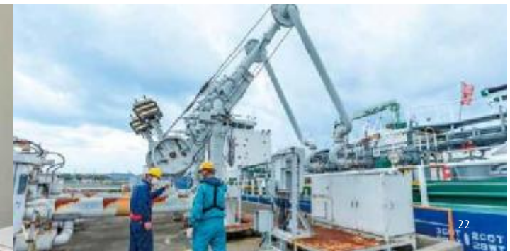
関西電力 赤穂発電所での燃料受入
