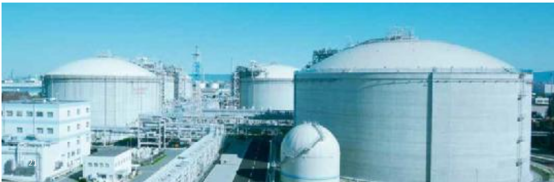
輸送されてきたLNGを貯蔵するLNG基地
