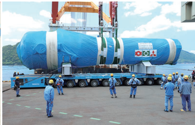
高浜3号機で蒸気発生器を入れ替える
