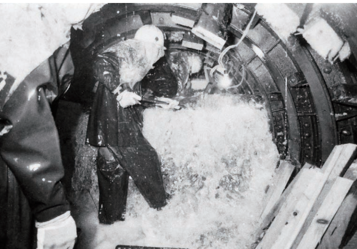
水抜きや薬剤注入などあらゆる手を尽くし破砕帯を突破した
