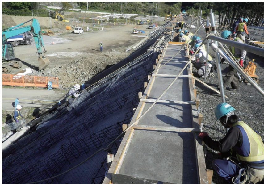
三陸鉄道南リアス線の復旧作業
