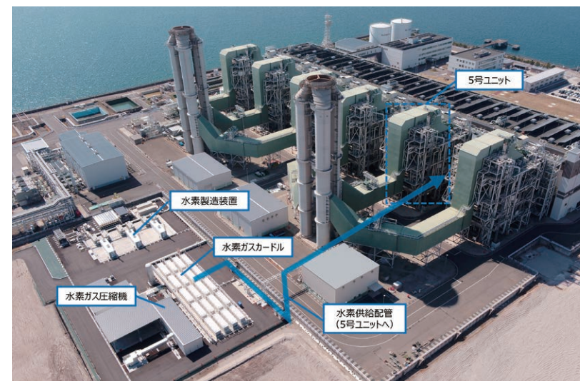
姫路第二発電所での水素混焼設備
