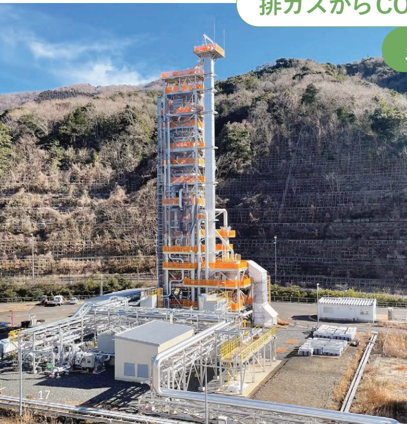
関西電力舞鶴発電所内のCO 2 回収設備 提供：川崎重工
