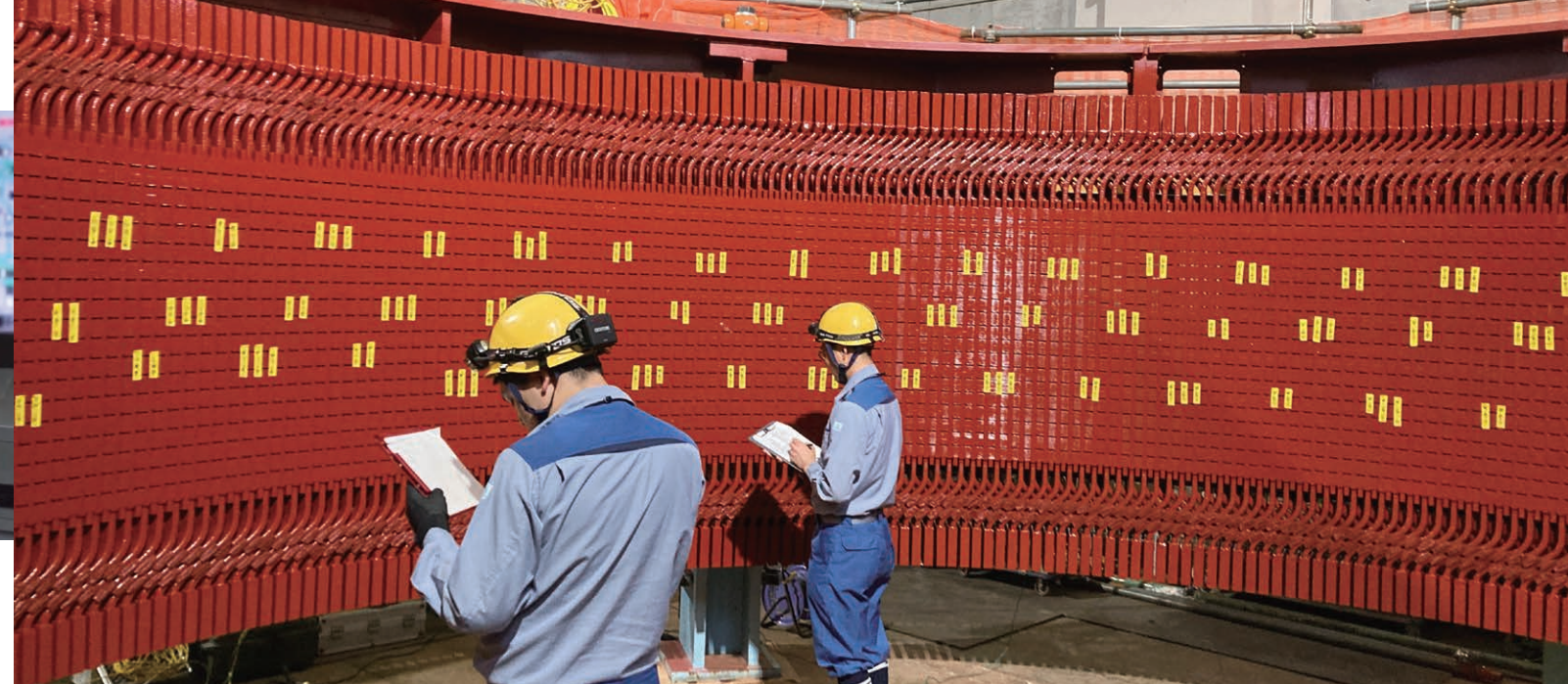
改良工事で更新する設備を入念に検査(笠置発電所)
