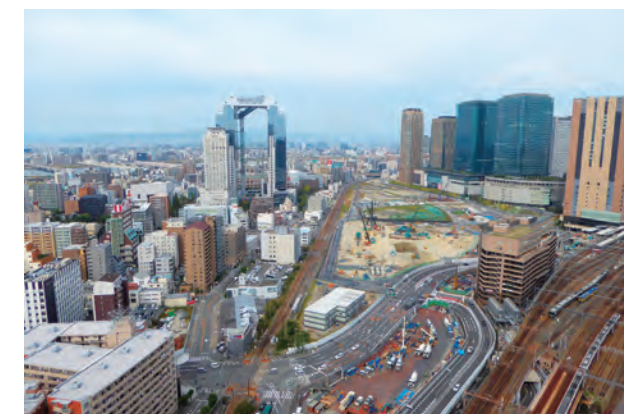
工事が進むうめきた2期地区
