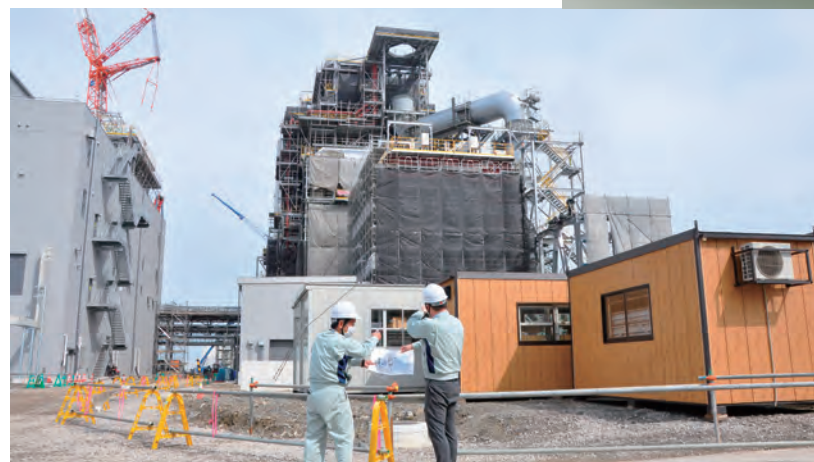
右 かんだ発電所(完成予想図) 左下 22年の営業運転開始を目指し工事が進む 右下 かんだ発電所長 定森一郎(中)
