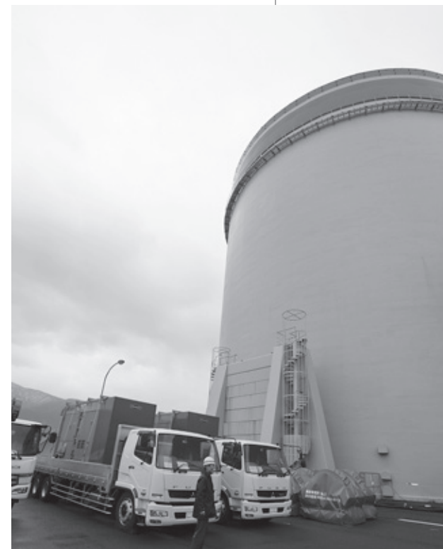
美浜発電所3号機
