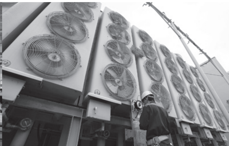
屋外の変圧器のメーターをチェック
