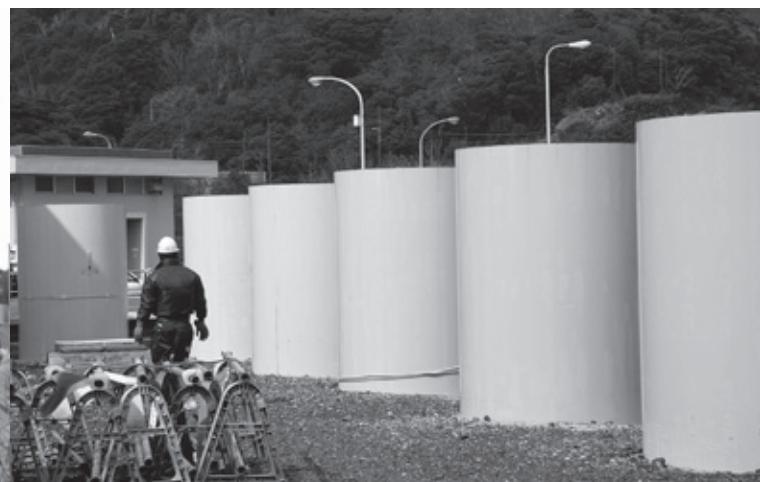
太い杭を打ち込み、建設中の全周防潮堤
