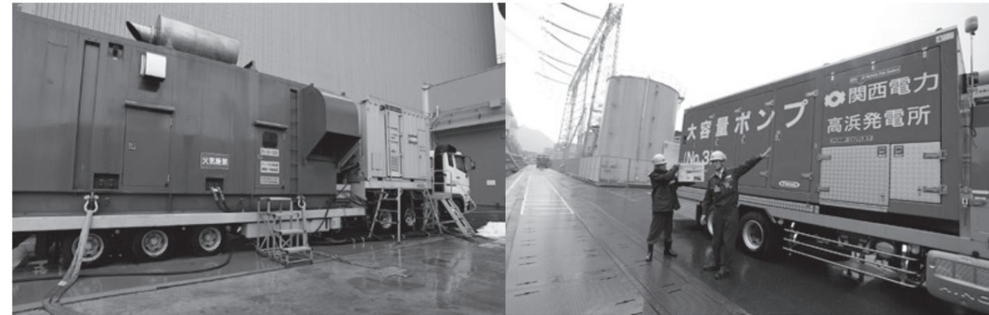
空冷式非常用発電装置。万一の事故が起きたとき、収束に必要な機器の電力を賄う
