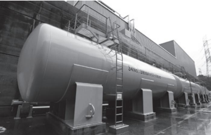
内部火災対策としての消火水バックアップタンク。
