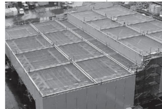
竜巻による飛来物防護対策として重要設備を頑丈な鋼材で覆っている
