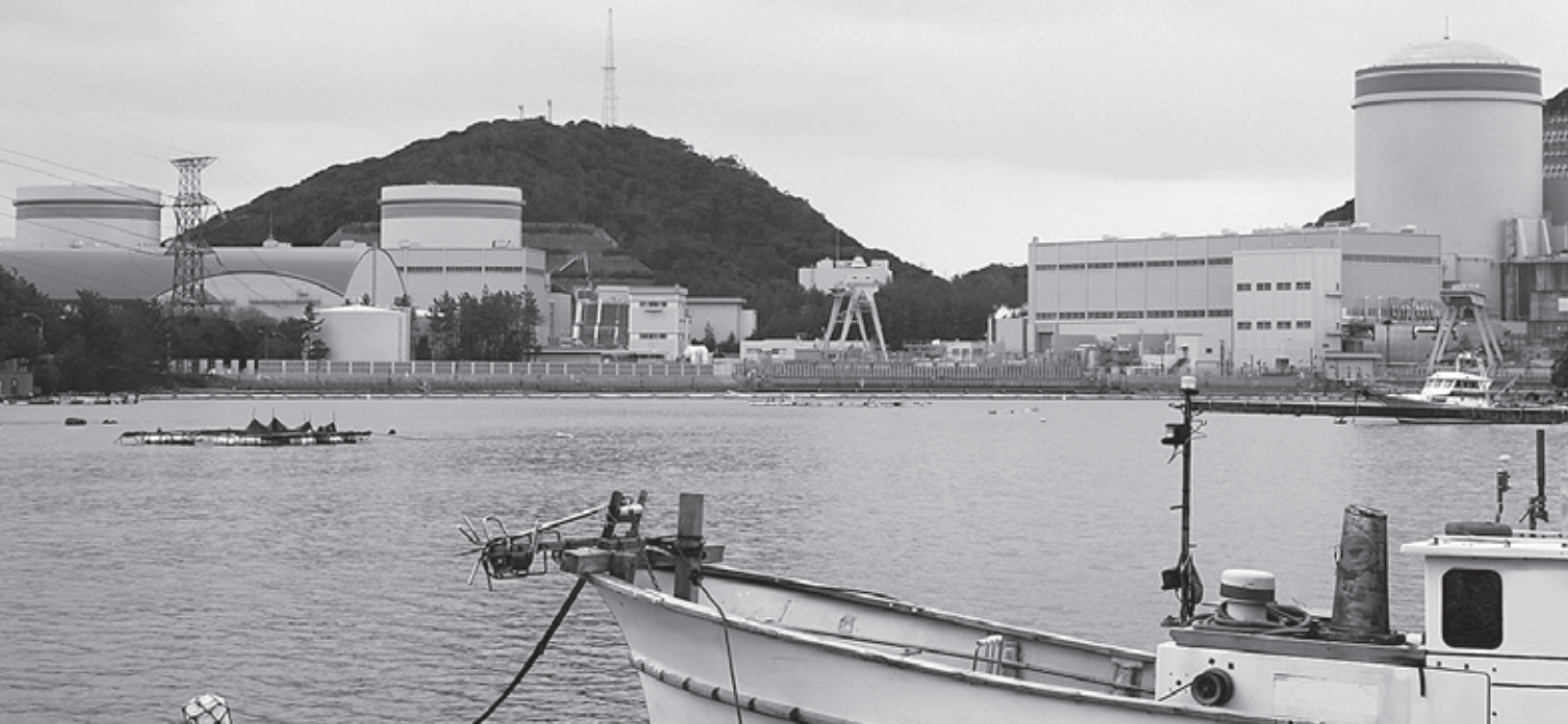
美浜発電所 向かって左から1号機、2号機、3号機
