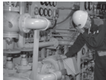
タービン建屋にて聴診棒で モーターの異音を聴き分ける補機員
