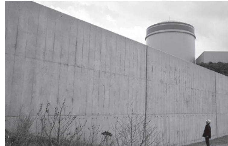
外海側に新たに建設された標高11.5mの防潮堤
