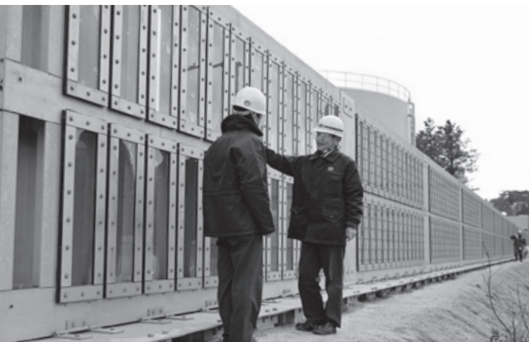
内海側、標高6mの全周防潮堤。 写真右が安全・防災室長の小寺さん
