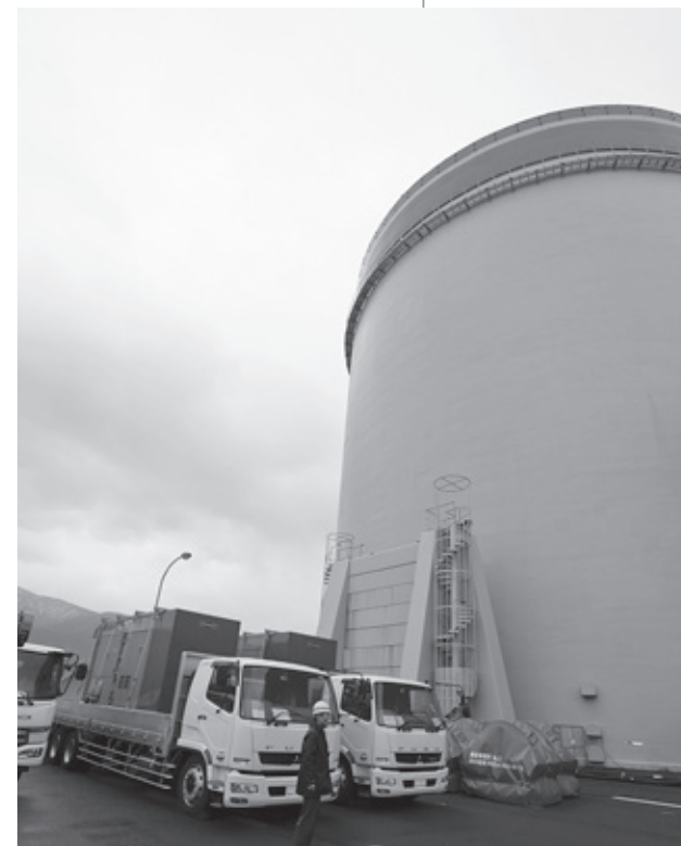
美浜発電所3号機
