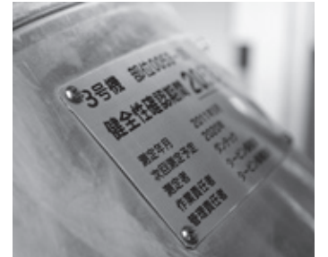
配管に留められたプレート
