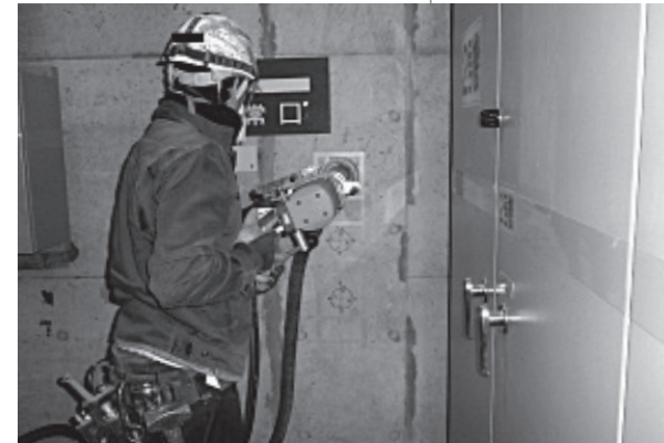
コンクリート構造物の 強度確認のためのサンプリング
