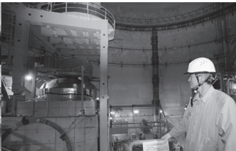
より安全性を高めるため、1994年に取り替え済みの蒸気発生器
