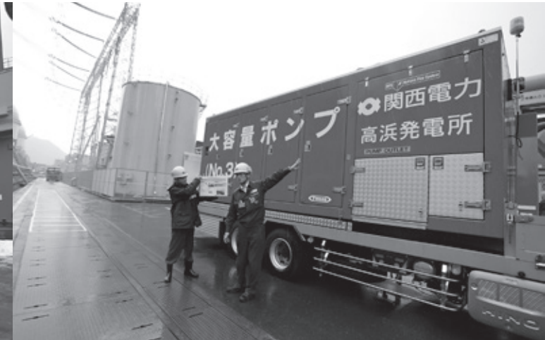
大容量ポンプ。海水ポンプのバックアップ用と放水砲の水源にも活用。3・4号機用に5台設置
