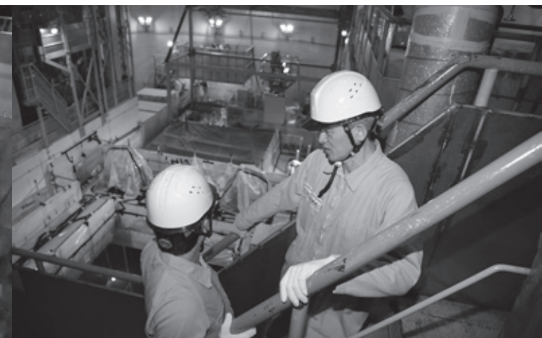
特別点検の作業状況を確認
