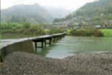
増水時に水面下に沈む「沈下橋」。欄干がないのは、増水時に流木や土砂が橋に引っかかり、橋が壊れることを防ぐため。戦後、特に1960年代以降、数多くつくられ、現在も住民の生活道として活躍。1998年、高知県は現存する47の沈下橋を重点的に保存・維持管理する方針を決定した。沈下橋は水面までの距離が近く、夏には橋から川に飛び込んで遊ぶ子供たちも多いとか。
