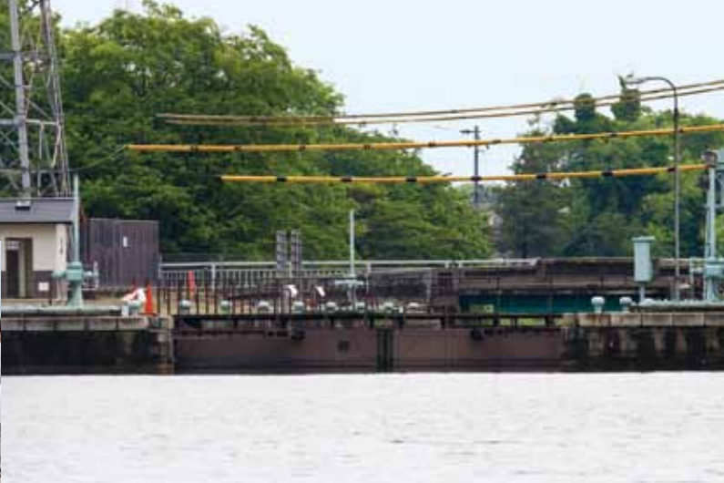
▲上流と下流で2.7mも水位差がある富岩運河の中流部に設けられた「中島閘門」。1998年、昭和の土木構造物では全国初の国の重要文化財(近代化遺産)に指定された
