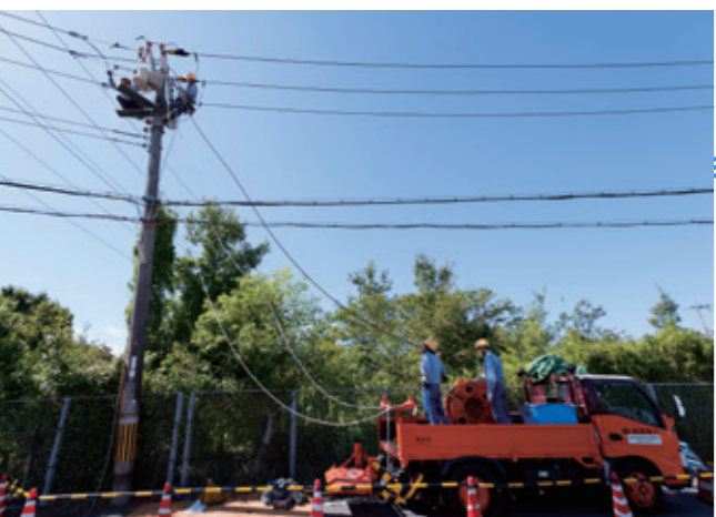
レジリエンス強化——配電線張替工事
