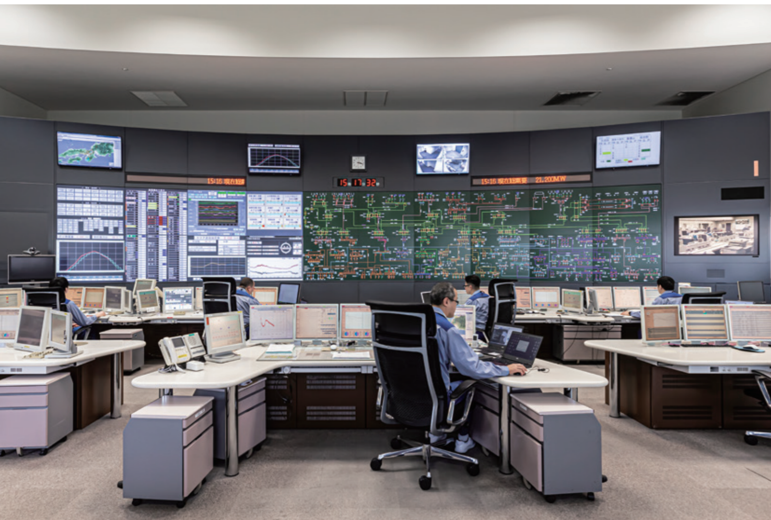
電力系統の需給調整を行う中央給電指令所
