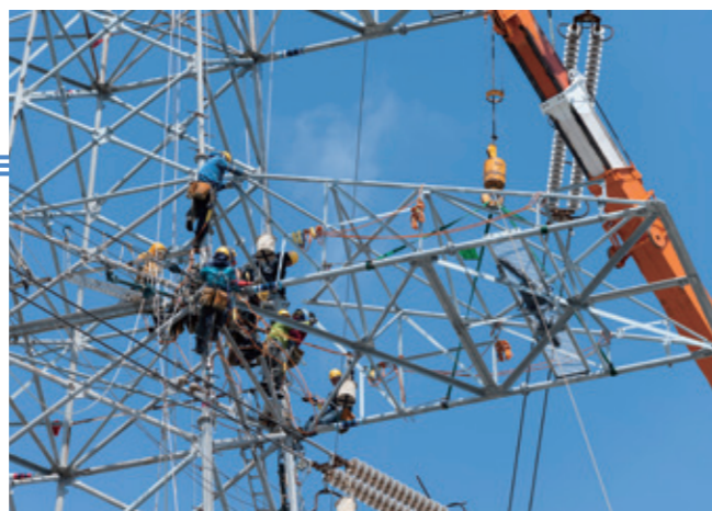
高経年化対策——送電鉄塔の部材取替工事
