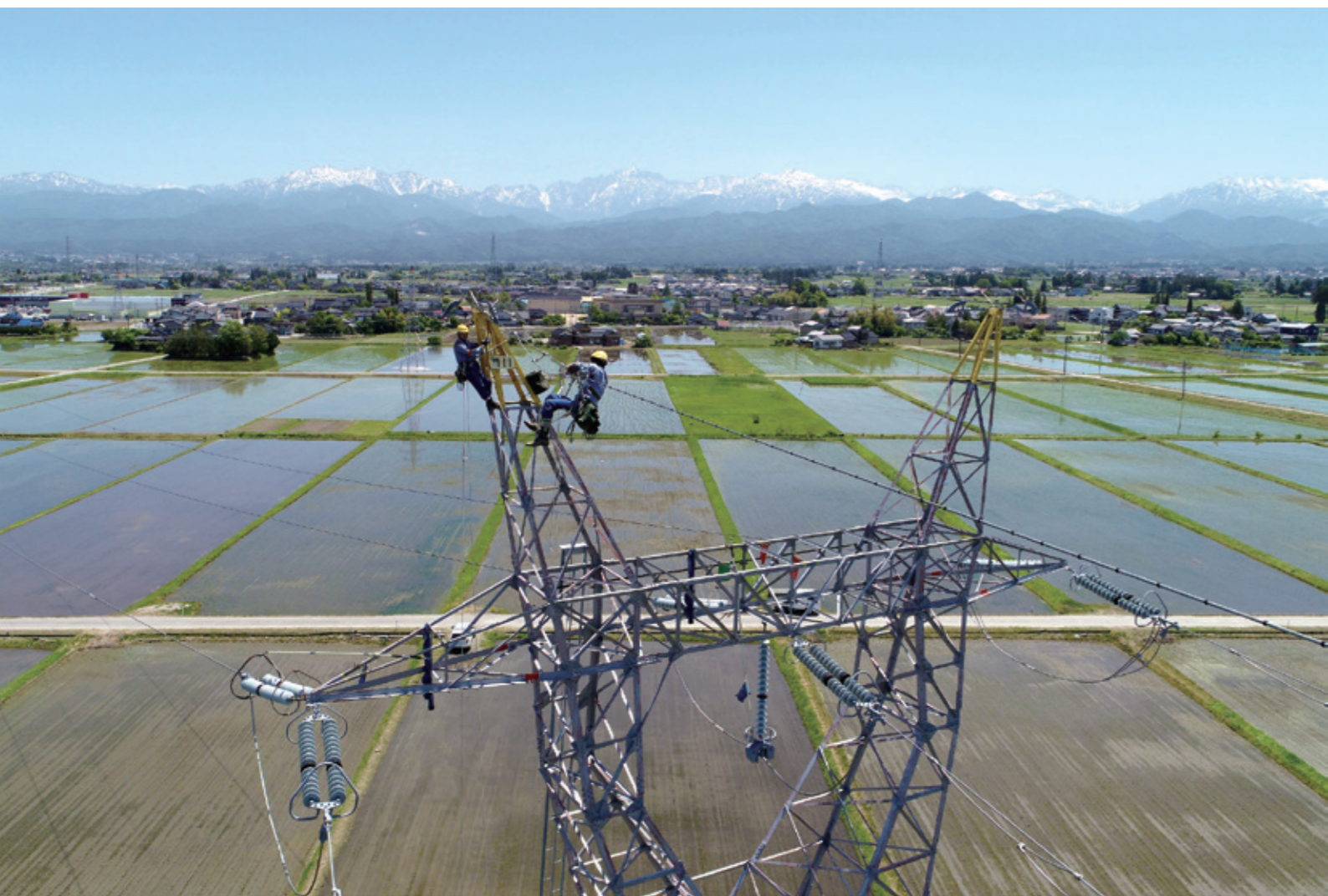
安定供給マインドを堅持しつつ、送電線のメンテナンスに挑む。 写真は黒部川第四発電所(くろよん)から関西方面へ電気を送っている送電線の保守(富山県立山町)
