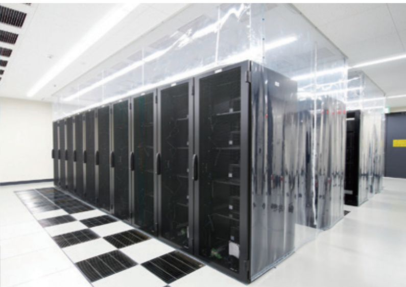
情報通信設備
