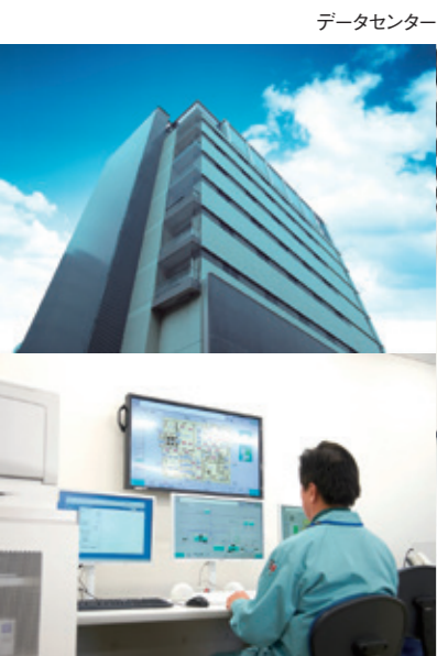
データセンター
