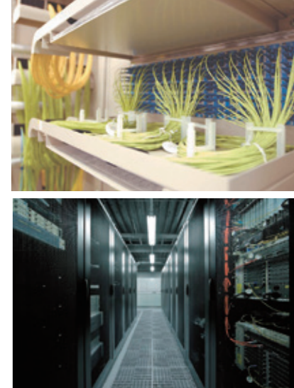
データセンター 情報通信設備
