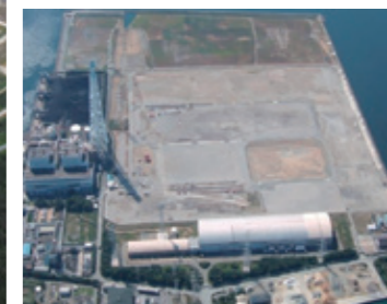
高砂発電所跡地
