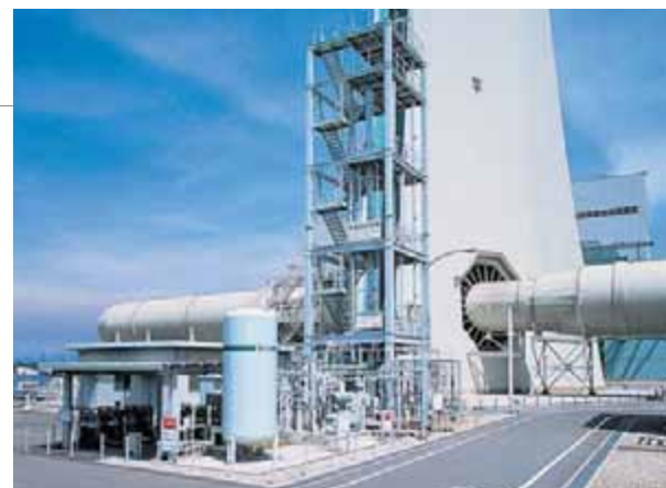
CO 2 分離回収(関西電力南港発電所)
