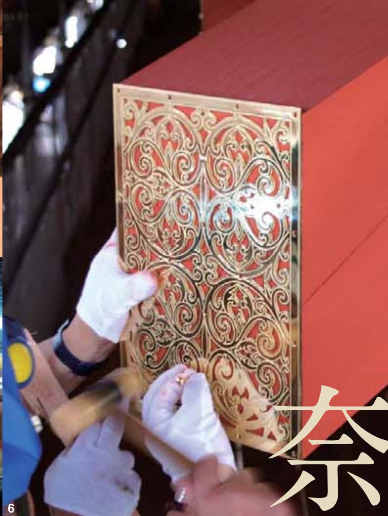
④大極殿正殿に掛けられる扁額(へんがく)の文字を検討する窪寺 茂さん ⑤平城宮跡内の遺構展示館で公開されている、奈良文化財研究所制作の大極殿復元模型(10分の1縮尺) ⑥復元中の、大極殿正殿の屋根を支える尾垂木(おだるき)木口金具の取り付け(提供:文部科学省)
