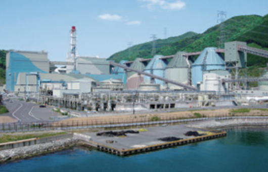
実プラント(舞鶴発電所)
