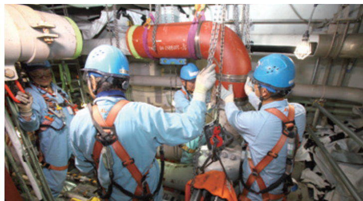
高浜1号機の配管新設工事
