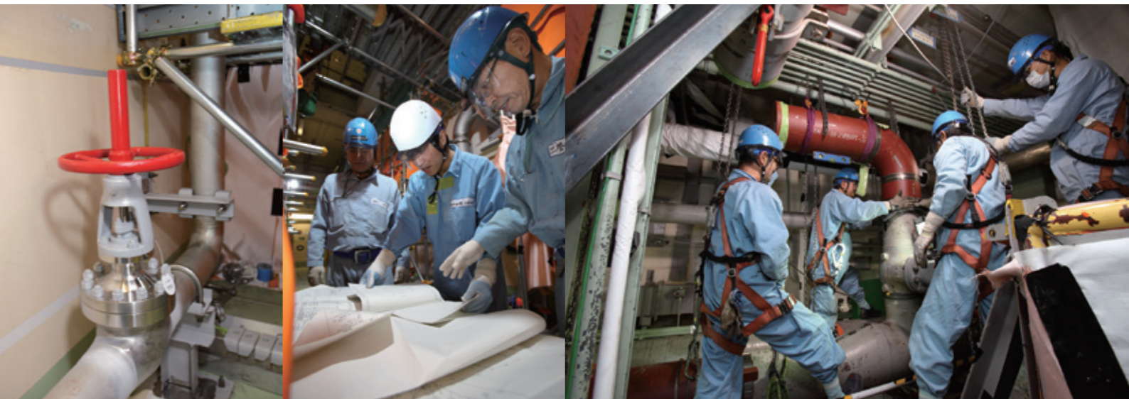
配管新設工事の現場
