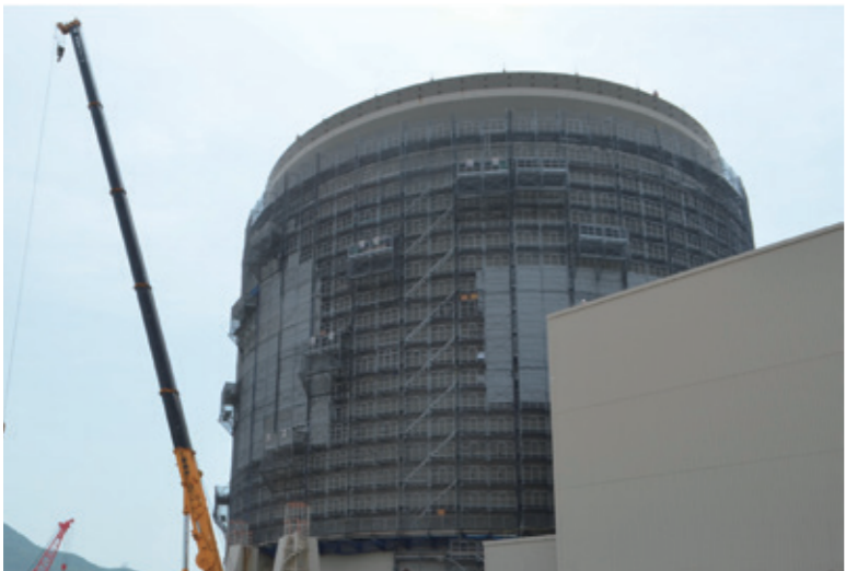
美浜3号機 外部遮蔽壁耐震補強工事
