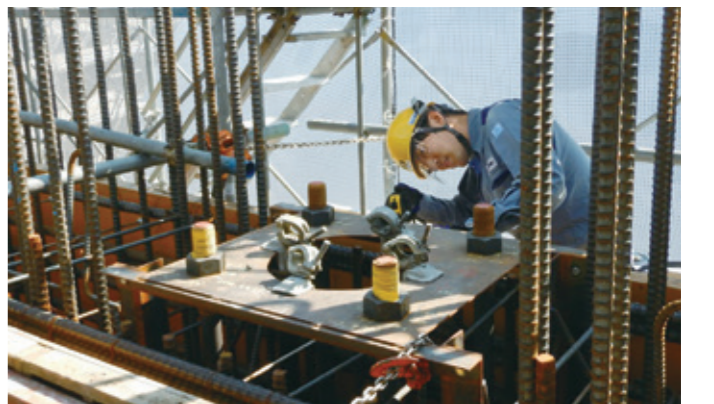
高浜1・2号機原子炉格納容器の上部遮蔽設置工事における鉄骨架台検査
