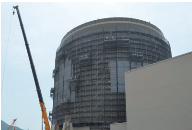
美浜3号機 外部遮蔽壁耐震補強工事
