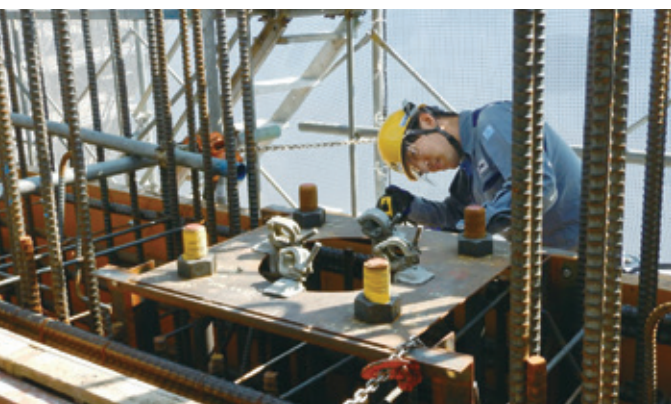
高浜1・2号機原子炉格納容器の上部遮蔽設置工事における鉄骨架台検査
