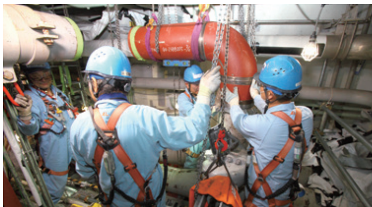
高浜1号機の配管新設工事
