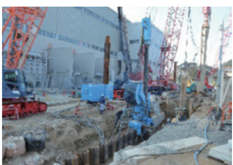
安全性向上対策工事が進む 美浜発電所の防潮堤設置工事
